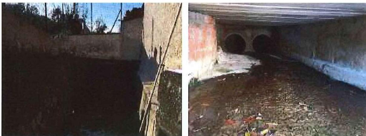
**Figura 6 – Imbocco della tombinatura costituita dai due tubi DN1000, preceduta da un tratto coperto con geometria rettangolare con larghezza e altezza variabili.**
