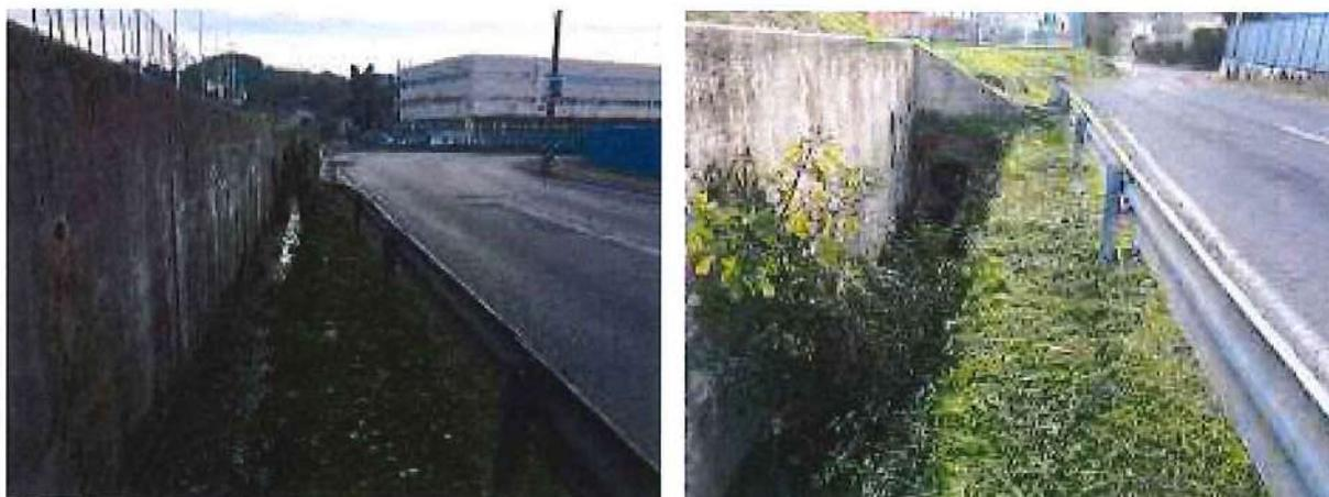
Figura 3 – Tratto di Fosso Tombone a monte di quello di studio: alveo a lato di via delle Pianazze (sx); imbocco della tombinatura DN1000 che recapita nel tratto in studio (dx).
